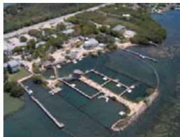
图片说明：美国佛罗里达州海豚研究中心 图片来源： http://www.dolphins.org/dolphin_lab.php
